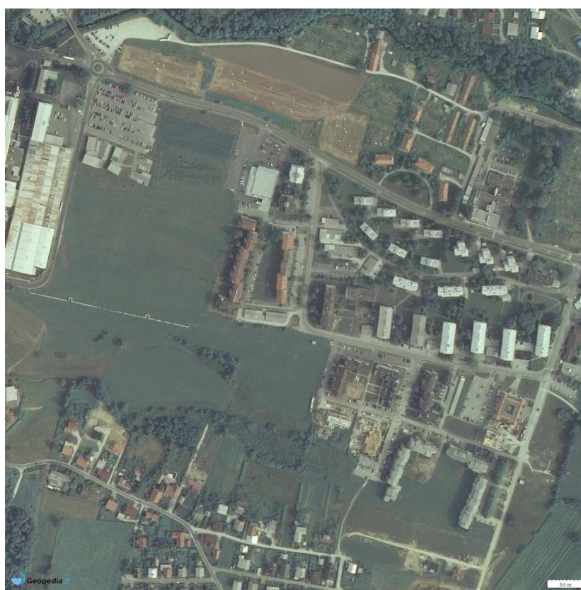
Slika 2: Blokovsko naselje z vidnim starim toplovodom
